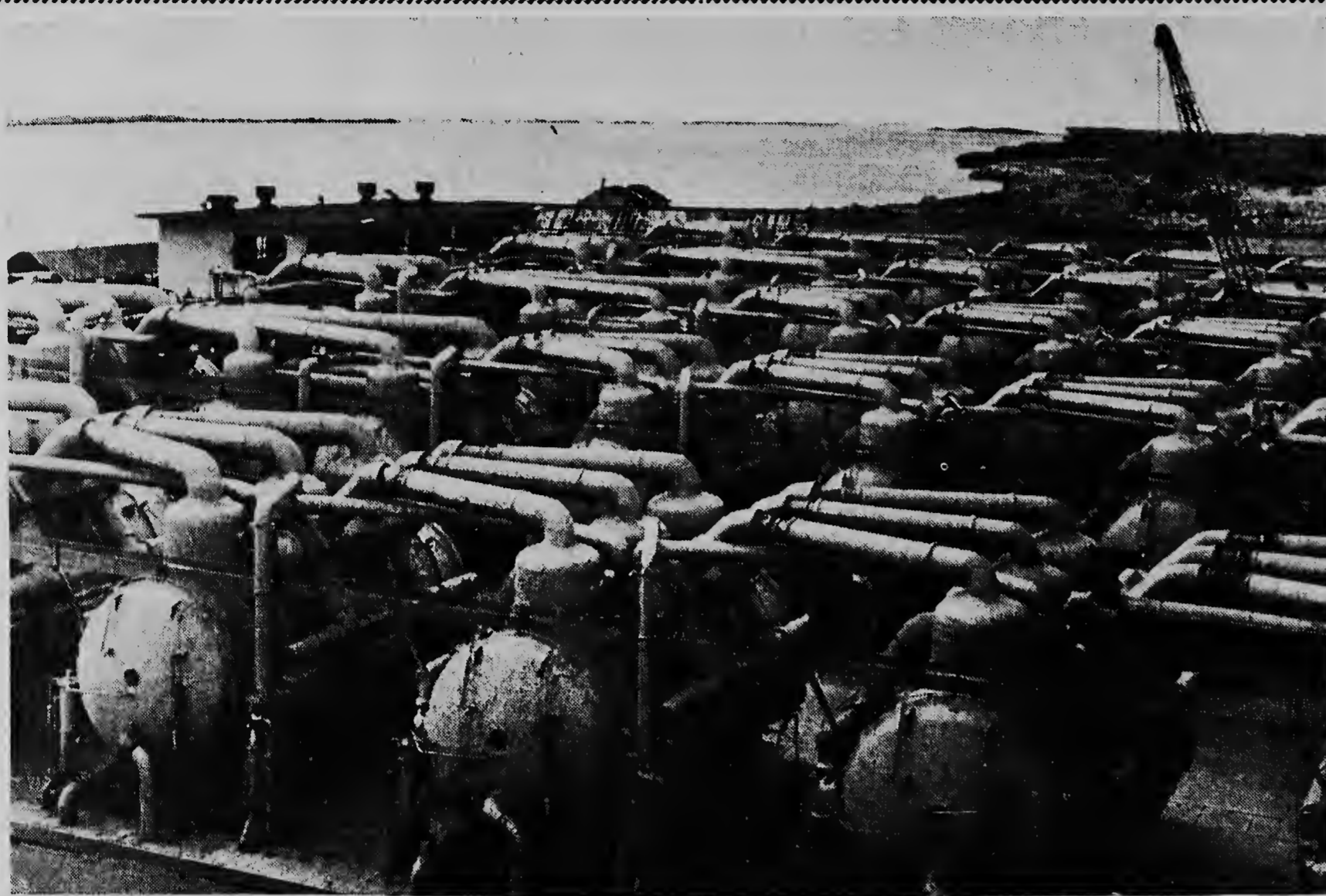
E UNANAN DI DESTILACION DI NOS PLANTA DI AWA Y ELECTRICIDAD
